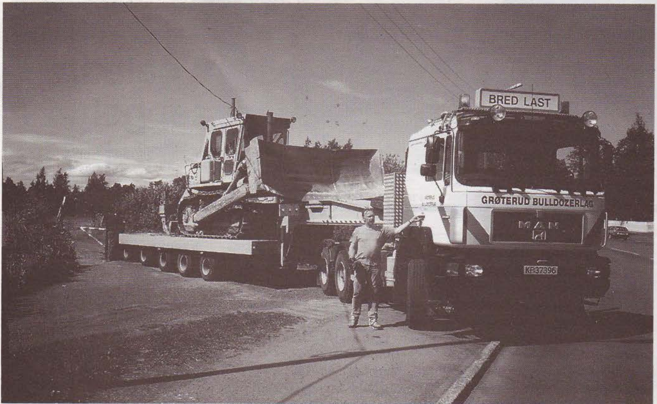
Grøterud bulldozerlag kommer til området.
