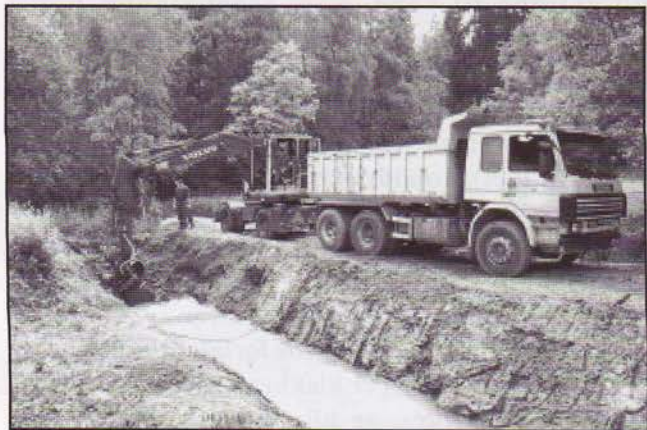
Vann- og avløpsetaten stilte med tungt utstyr for å fjerne jord- og leirmassene ved åpningen av Østensjøbekken.
