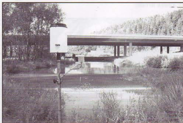
Rensedammen under E6-brua. I forgrunnen noen instrumenter for bl.a. måling av nedbør.
