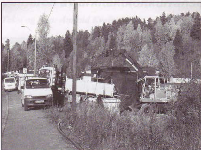
Gravearbeidet på Kvernjordet ved Østensjøveien.
