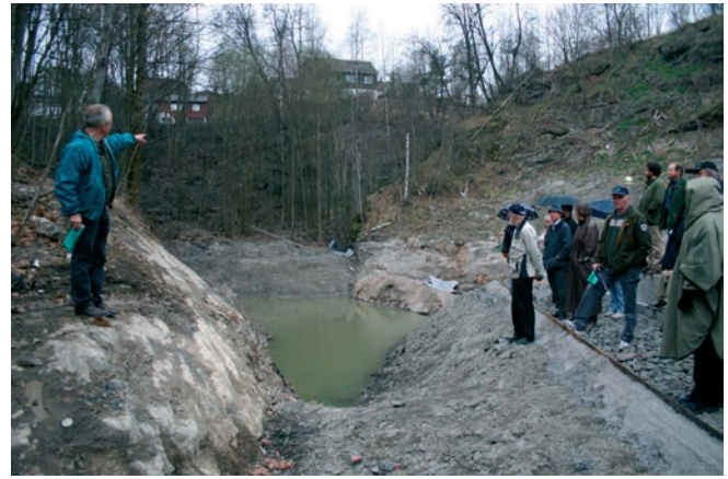
Vannparken på Hølaløkken, litt nord for Grorud stasjon, under arbeid i april 2004. Dette er det første virkelig store gjenåpningsprosjektet i elvas historie. I september samme år ble vannparken offisielt åpnet.
