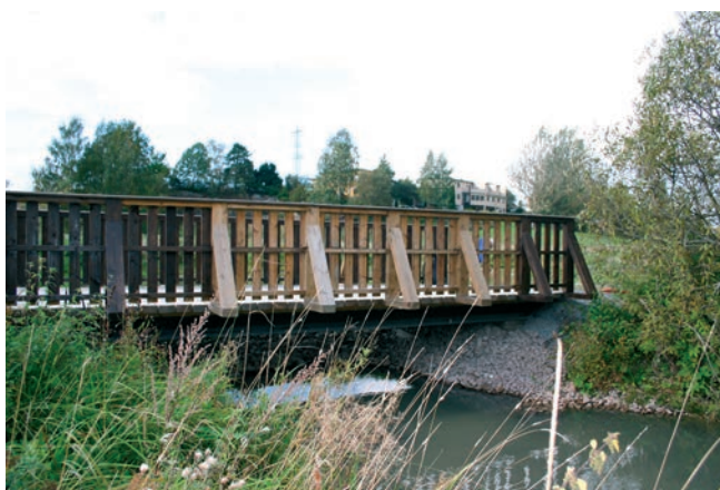
Langerudbekkens utløp i kanalen, ETTER omleggingen.
