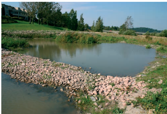
Dammene er atskilt med steinsettinger som vannet filtreres gjennom. Vi ser også en øy som rasteplass for fugler.
