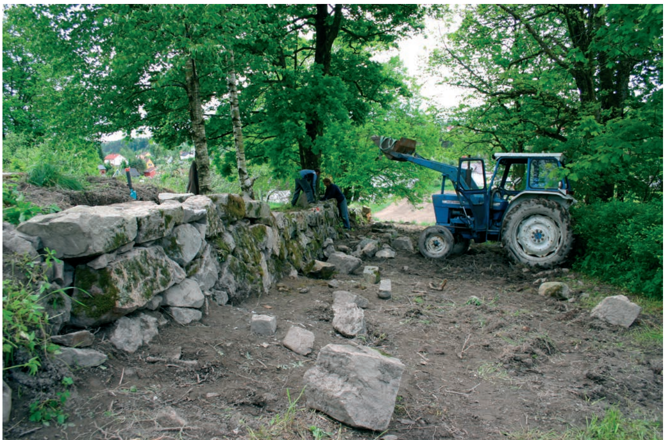
Rehabiliteringsarbeidet er i gang med Asgeir Føyen på Abildsø gård som tørrmurbygger.
