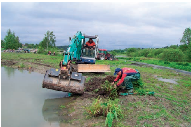
Per Tokle setter ned en plante i hullet som maskinen har gravet ut.
