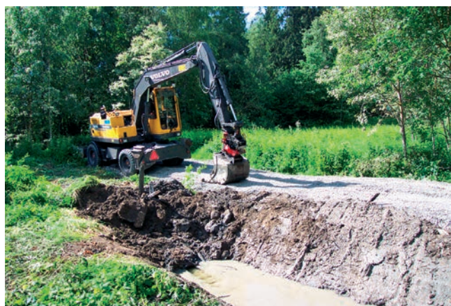
Åpning av Østensjøbekken i nordenden
