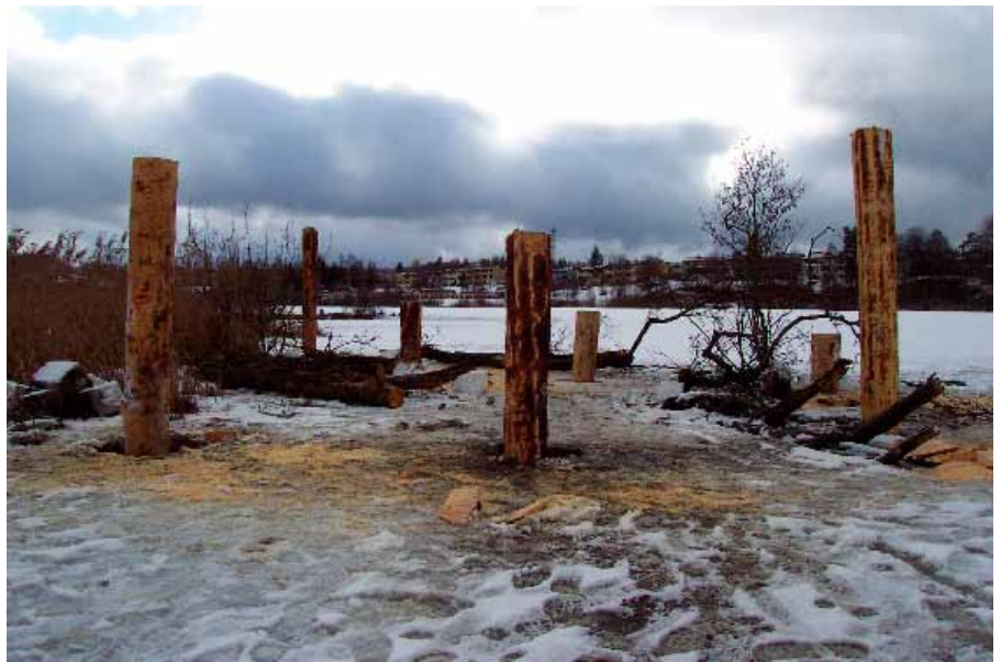
Slik så det ut i mars 2004 etter at de syv pelene var trykket ned ved hjelp av en lang kranarm.
