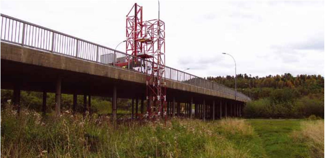
Østensjøbroen under oppussing i september 2003, 39 år etter at den ble anlagt.
