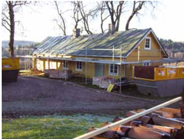
Taket på Drengestua får samme behandling som driftsbygningen.
