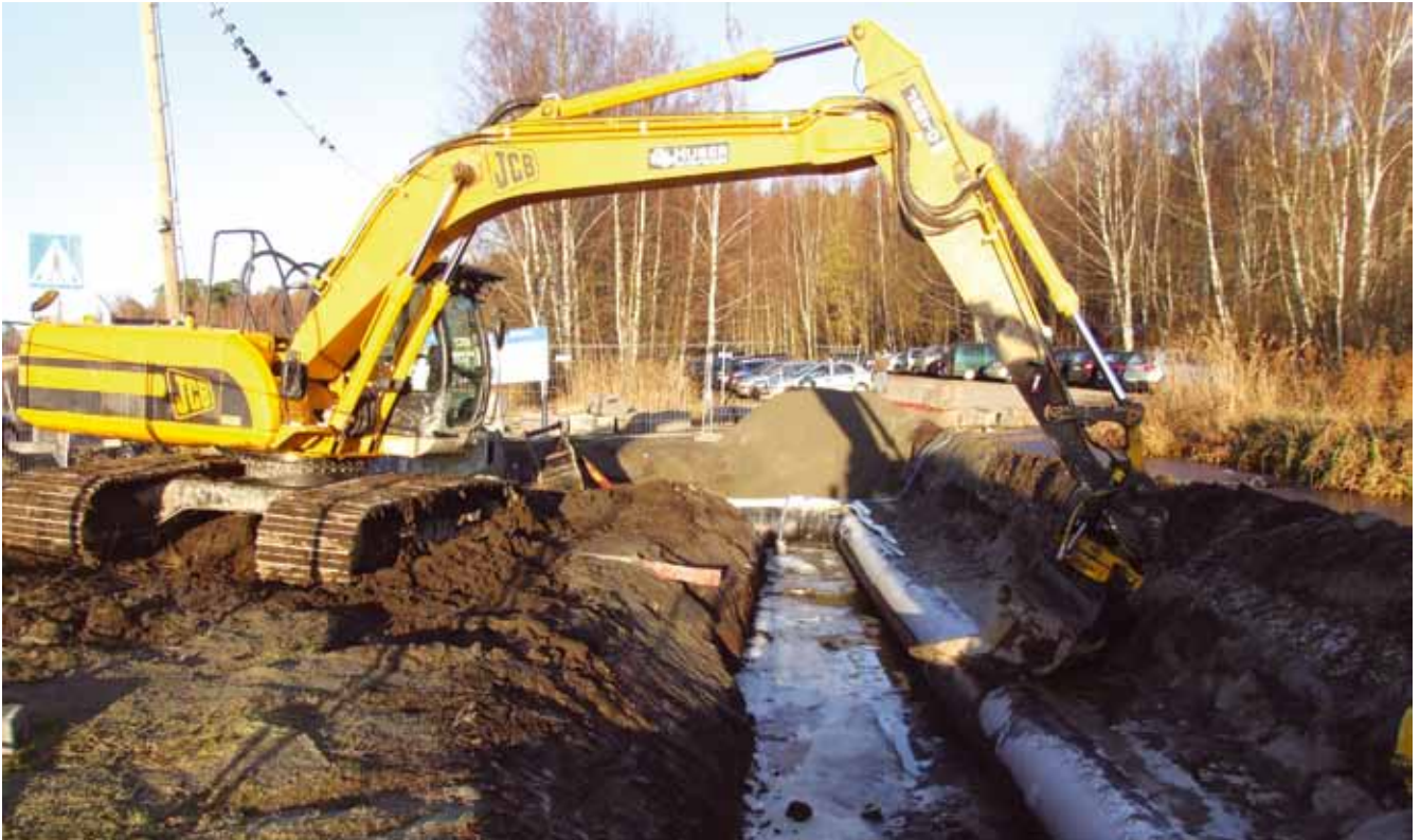
Her legges fjernvarmerør litt sør for parkeringsplassen.
