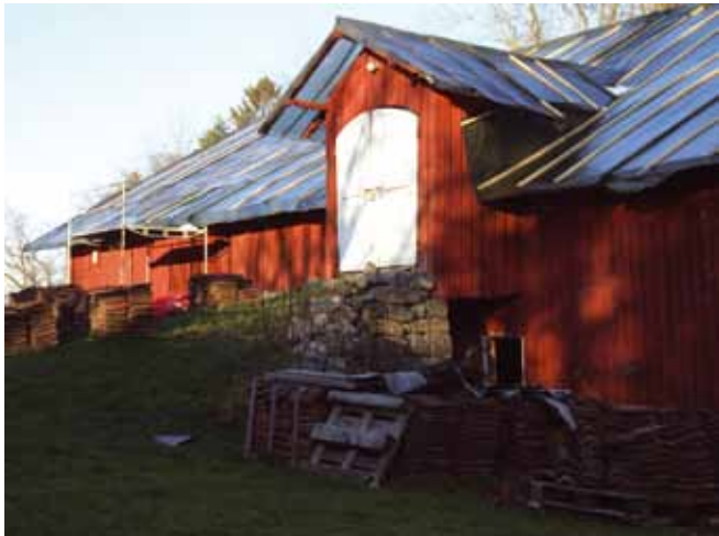
Taksteinene på driftsbygningen er hentet ned fra taket og restaureringen er i gang.
