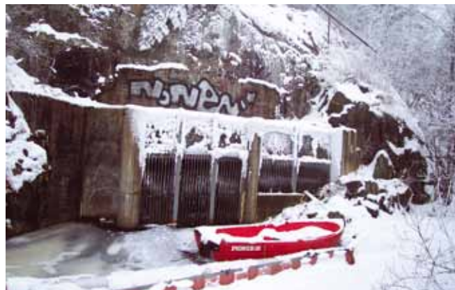
Kulvertutløpet kan best sees om vinteren fra isen på betryggende avstand.
