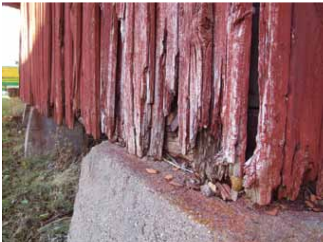
Alle deler av bygningen har vært i svært dårlig forfatning og det er viktig å gjøre jobben grundig nå.
