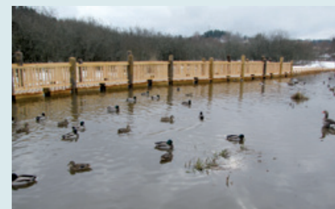
Etter at fjernvarmerøret var lagt i 2009 ble det bygget en gangbro fra parkeringsplassen i sør i retning Bogerudmyra. Hafslund bekostet prosjektet. Gangbroen gjør det mulig å komme tørrskodd fram over det våte partiet, spesielt i vårløsningen.
