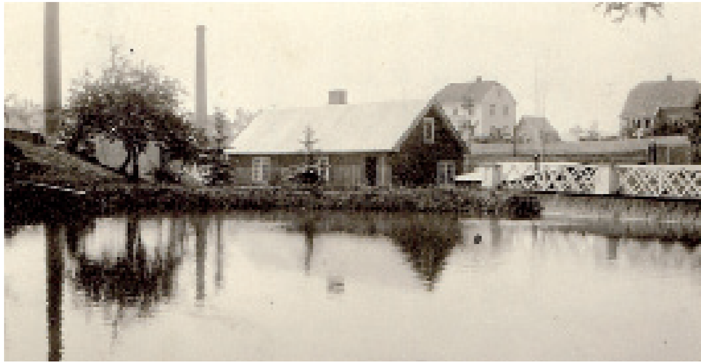
Dette bilde er tatt ca. 1930 med "Den gule stue" sentralt i bildet. Omtrent på denne tid ble trolig bro og demning rehabilitert. Dammen er velfyllt og vesentlig større enn i dag. Den nærmeste skorsteinspipen tilhører Høyenhall Fabrikker, den lengst vekk Høyenhall teglverk.
