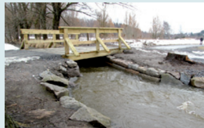
Tregangbru over Bølerbekken i syd ble bygget i 2009 som en utbedring av semen-trøret under turveien. Tidligere kom ikke vannet gjennom røret med den følge at jordmasser ble skyllet vekk og veien satt under vann, dvs. ufremkommelig for fotgjengere.
