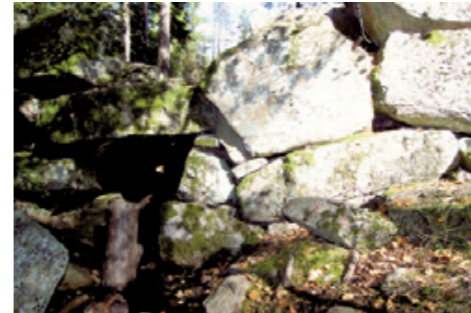
Dette er steinfyllingen eller tørrmuren ved Skøyenputten fra 1876. Det er trolig samme teknikk som ble brukt ved den første demningen i Mølledammen.
