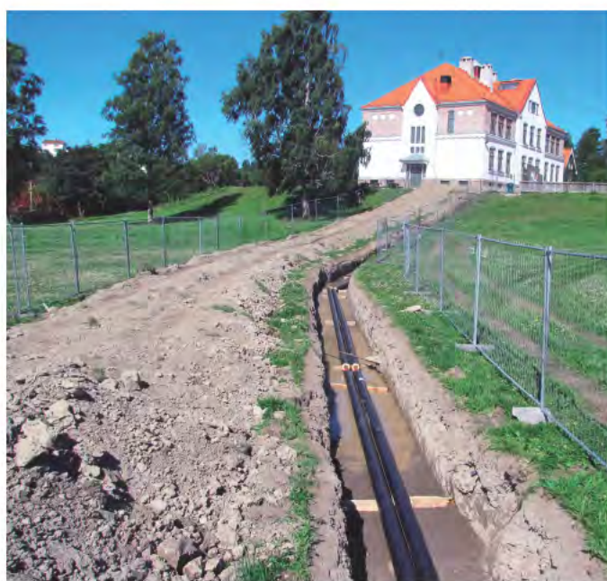
Spredenettet med fjernvarmerør føres inn til Østensjø skole.
