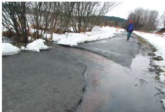
Avrenningen eroderer turveien og bryter ned breddene. Derfor er det viktig å kontrollere tilløp og utløp.
