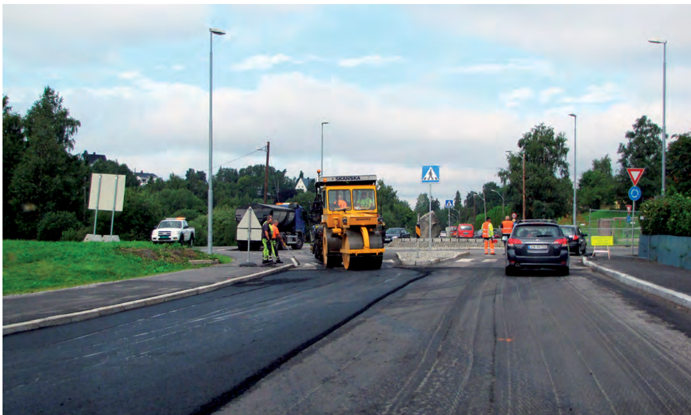
Asfaltering ved rundkjøringen Østensjøveien/Haakon Tveters vei.
