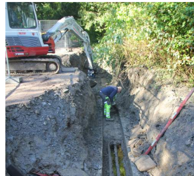
Oljелеkkasje påvist nederst i Manglerudbakken. Oljefilmen glinser.
