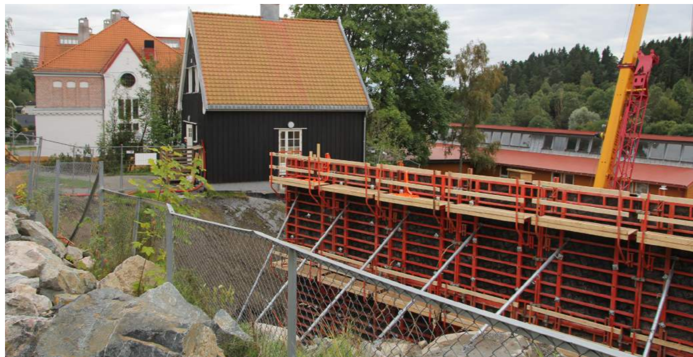
Gymsalen under oppføring. Skolebygningen til venstre og den gamle vaktmesterboligen på "stupet" mot byggeplassen 25. august.
