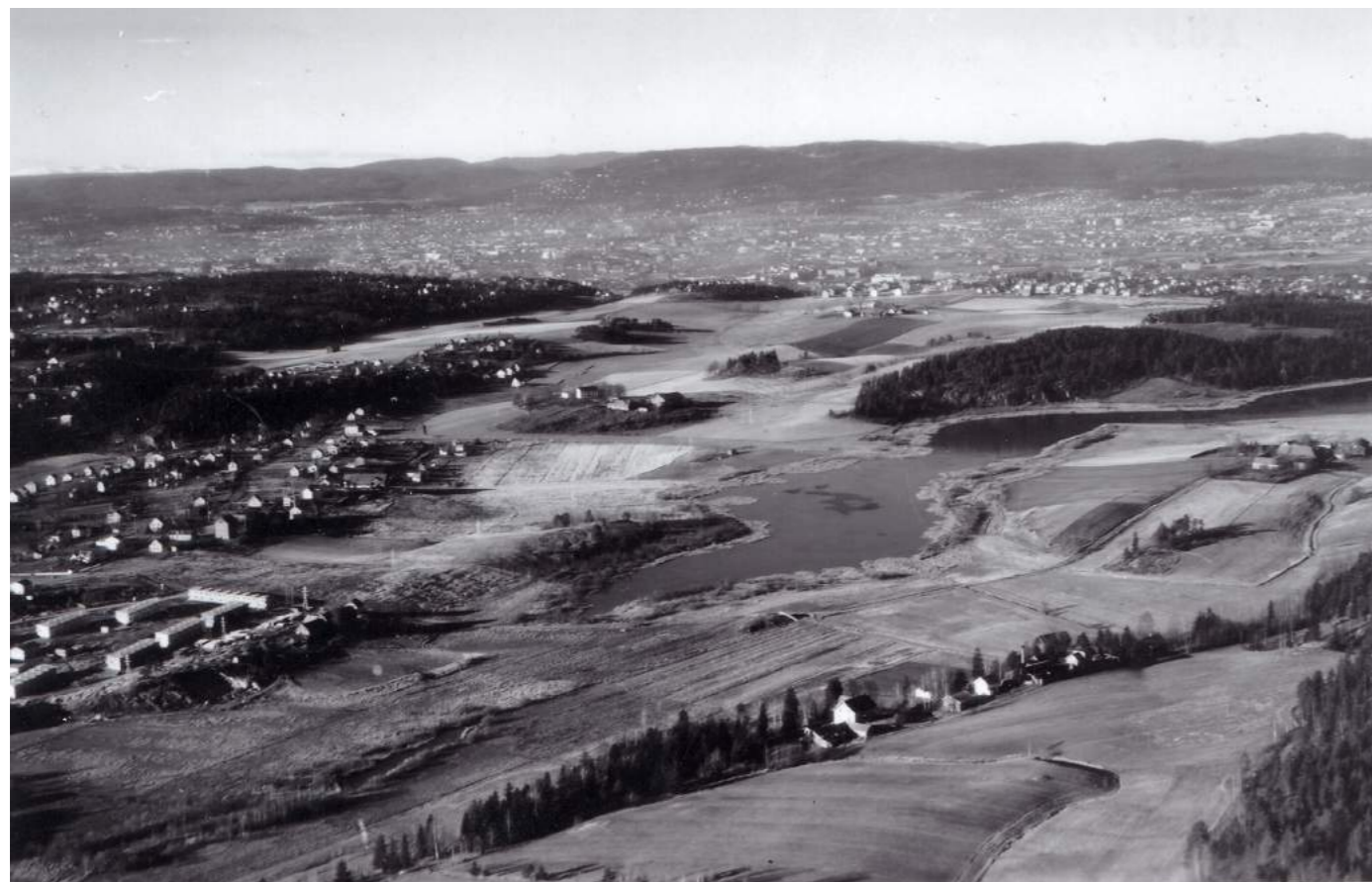
Etter sammenslåingen med Aker i 1948 hadde byen store arealer til disposisjon for boligbygging, og man slapp å fortette og bygge ned grøntområdene. Foto: Widerøes Flyveselskap 1948/Østensjø lokalhistoriske bilder.
