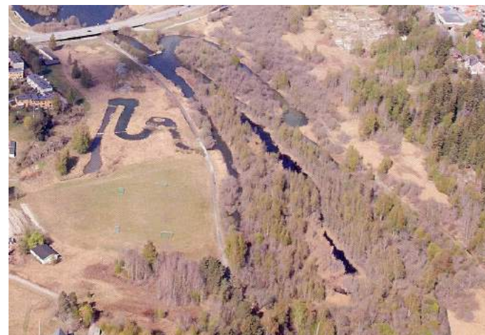
Klopptjern fremtrer som et langt bekkedrag midt ute på Bogerudmyra. Kanalene som ble gravd ut går rundt hele myra. I nordøst er det en øy slik at hele området danner to øyer, en stor og en liten. Langerudbekken rensepark fremstår som en bekk med fem dammer. I nord erosjonsterskelen mot Østensjøvannet. Nederst til venstre Bakkehavn. Foto: Utsnitt av bilde tatt av Jon Markussen hos Fylkesmannen i Oslo og Akershus i 2011.
