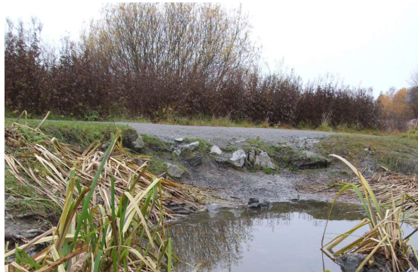
Variierende vannstand vasker ut den opprinnelige våtmarka som veien er anlagt på. Flyttingen av den eksisterende turveien er helt nødvendig for å gi naturen en sjanse til å skape en mer robust bredd. Foto: Amund Kveim 2012.
