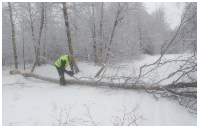
Store trær står ytterst på en del øyer. Dersom de store trærne velter, vil de bryte opp øyene og ta med seg store mengder jord. Erosjonsproblemene vil øke. Derfor har Fylkesmannen gitt ØVV i oppdrag å felle en del større trær på en av øyene på vestsiden i søndre del av vannet.
