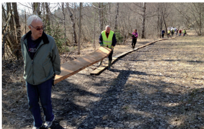
På stien nedenfor slåtteeenga Sjøli er det lagt ut klopper. Stien er svært våt samtidig som det blir stor slitasje på vegetasjonen. Per Arne Holt foran med et bord og Kjell Maalo bak. Inger Johansen bak med en bunt stokker som underlag til kloppene.
