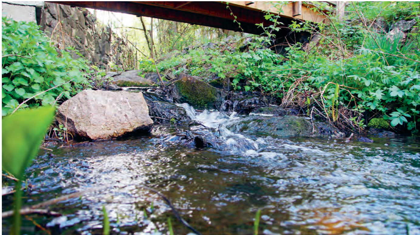
Østensjøbekken renner ut i Mølledammen. Dette er det siste vi ser av den opprinnelige bekken før den fortsetter i rør til den møter Alna-elven ved Bryn jernbanestasjon. Øverst til venstre Østensjøveien. Broen i overkant av bildet er rehabilitert som del av stien i hageanlegget. Foto: Leif-Dan Birkemoe.
