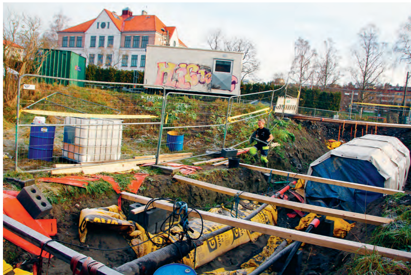
Mange har sikkert lagt merke til stadig tilbakevendende gravearbeid vest for Østensjøveien ved Østensjø skole. Kablene har ligget i et åpent hull i flere måneder. Infratek, et firma innen sikring av kritisk infrastruktur, jobber med utbedring av kablene etter oppdrag for Hafslund Nett. Bildet er tatt 30. oktober 2014.
