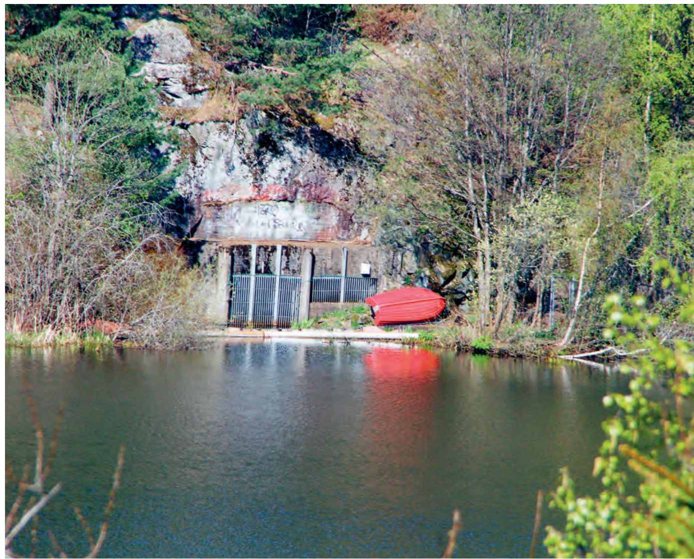
En fjelltunnel leder i dag det aller meste av vannet ned til Alna ved Bryn jernbanestasjon. Åpningen i fjellet er sperret av et gitter og når hevertmekanismen er i drift høres gjerne en summing som av en motor.
