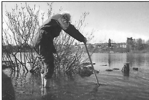
Johan Mollatt balanserer på stokkene i Østensjøvannet. Tverrstokkene på Påskeøya lå under vann og dypere enn beregnet. Stokkene har trukket vann og presset konstruksjonen ned. Nå gjelder det å heve stokkene så plattingene blir liggende tørt.
