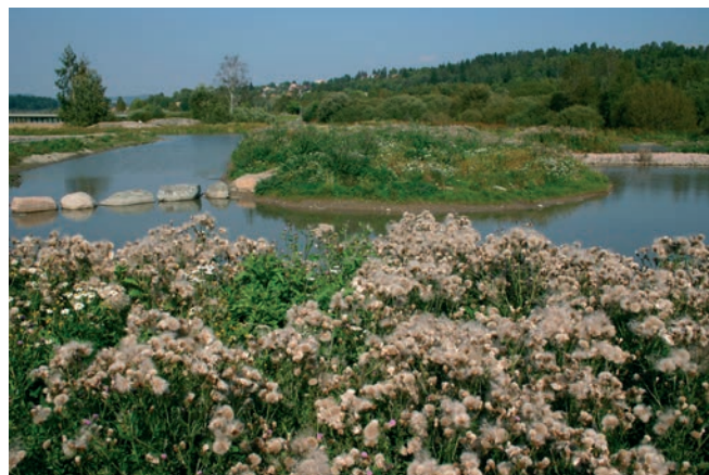
Til venstre sees «hoppesteiner» som gjør det mulig å gå gjennom anlegget. Vegetasjonen har gjennom sommeren tatt seg kraftig opp.
