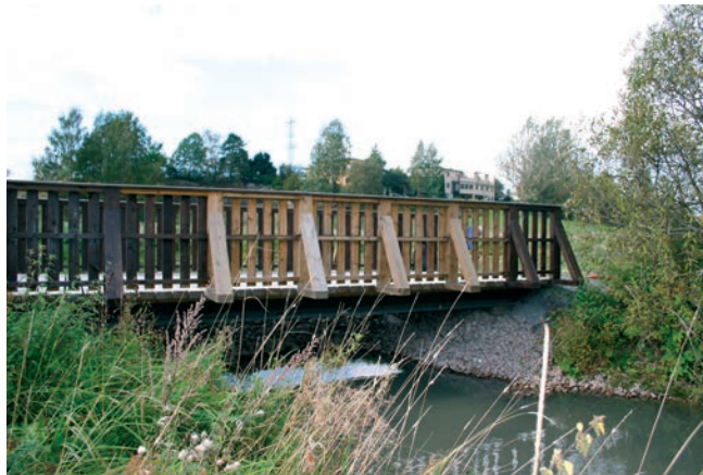
Langerudbekkens utløp i kanalen, ETTER omleggingen.
