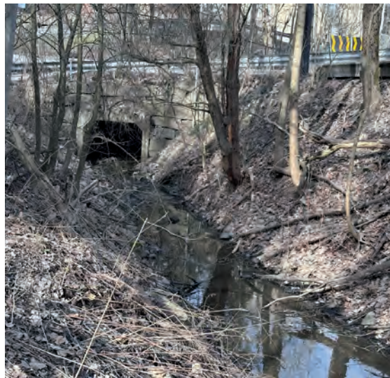
Harry Fets vei går over Rognerudbroen i krysset ved Østensjøveien. Det var like i forkant av broen at det ble bygget en nåledam rundt 1910. Foto: Leif-Dan Birkemoe.
