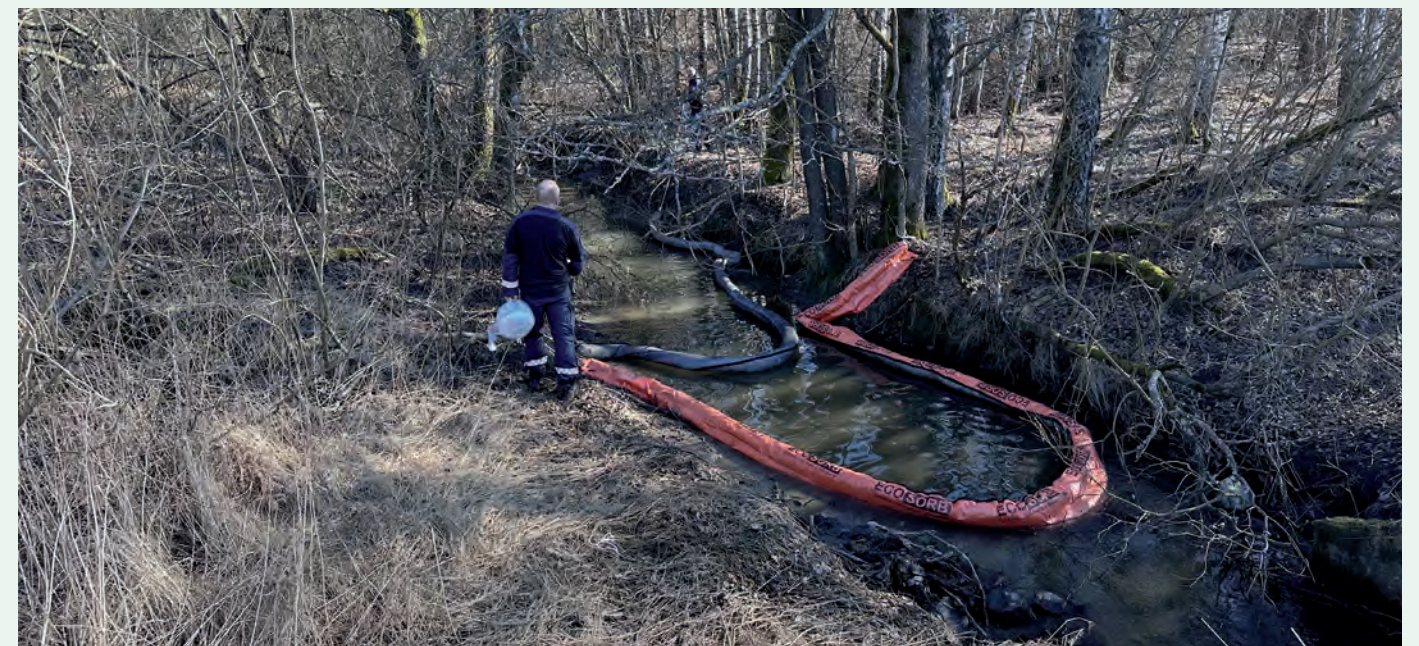
Brannfolkene la ut lenser på oversiden av broen der Bølerbekken går under Østensjøveien.
