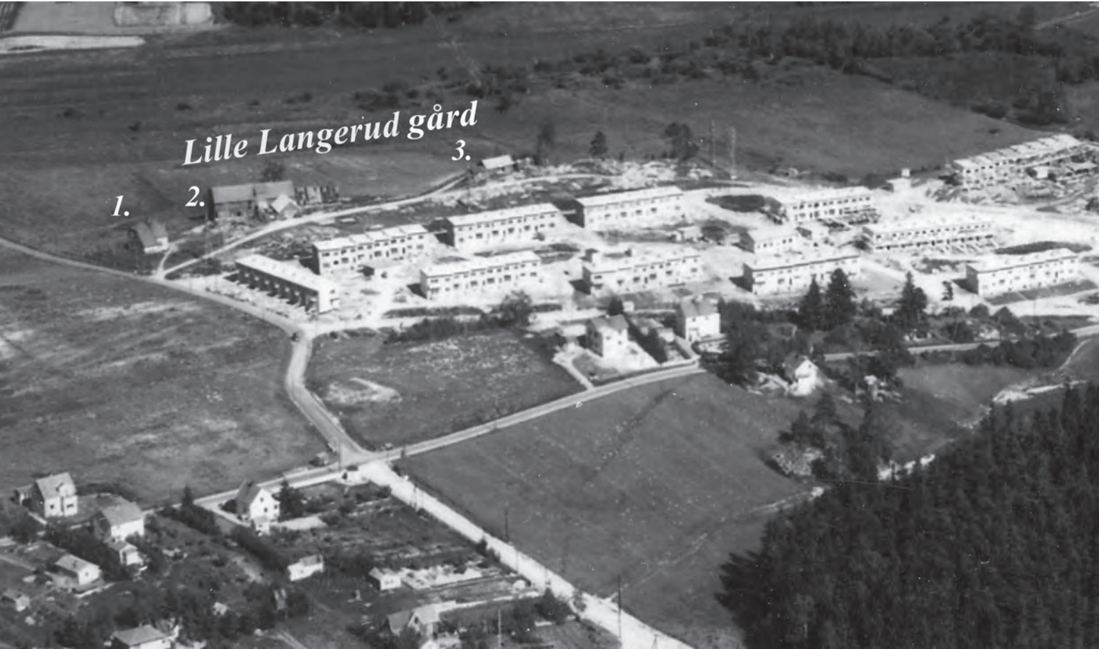
Boligfeltet Lille Langerud Sambyggelag under oppføring. Bildeutsnittet viser forpakterboligen (1) rett ved Østensjøveien. Deretter driftsbygningen (2) og lengst til høyre en lade (3). Langerudsvingen 2-8 ble bygget der gården hadde ligget. Foto: Fjellanger Widerøe 1948.
