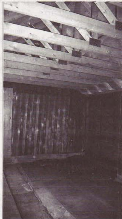
Veggen mot stallen. Merk renna i gulvet.
