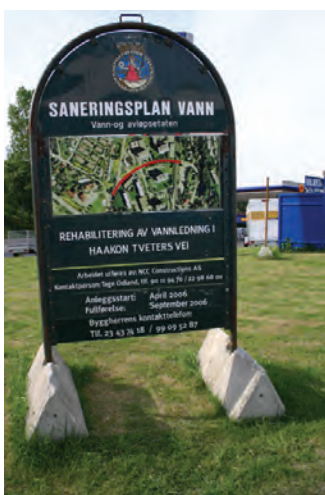
Avløps- og drikkevannsrør blir stadig rehabilitert.
