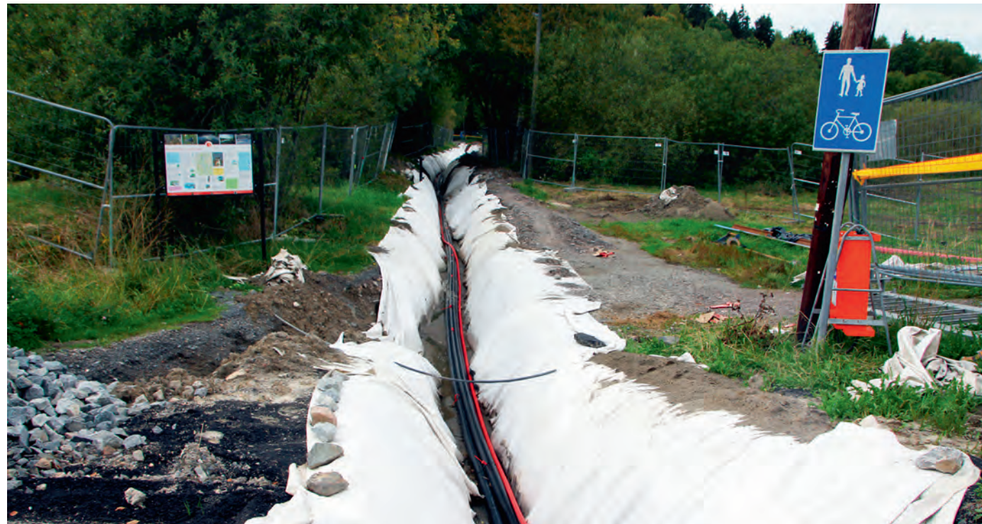
Høyspentkabelen ble lagt i turveitraseen. Her inn fra rundkjøringen Haakon Tveters vei/Østensjøveien. Foto: Leif-Dan Birkemoe, 18.09.2015.
