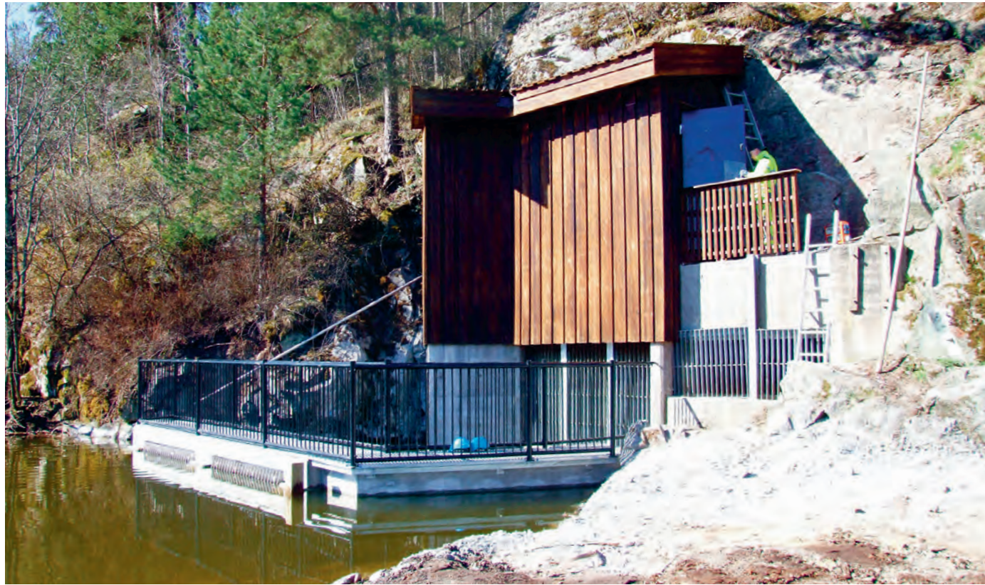
Damluken er plassert i den mørke trekonstruksjonen i vannets nordvestre hjørne og kan styres fra Vann- og avløpsetatens kontorer. Foto: Amund Kveim, 21.04.2015.
