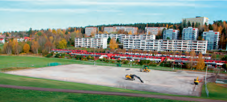
Rustadfeltet etter at det gamle dekket er fjernet og avretting påbegynt. Foto: Leif-Dan Birkemoe, 23.10.2015.
