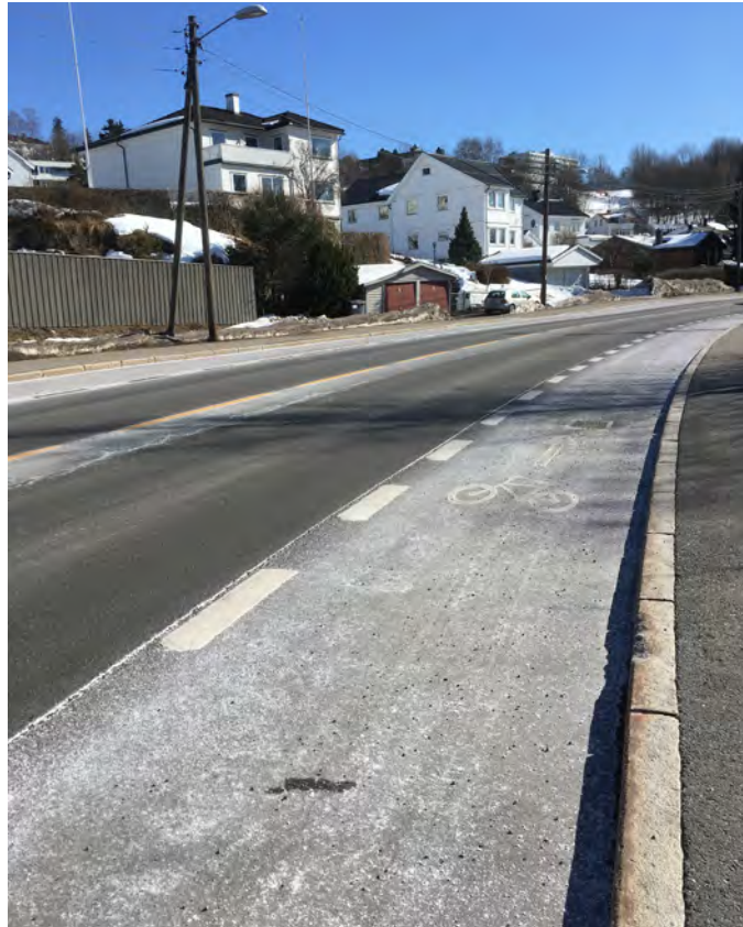
Det hvite belegget i Østensjøveien og Eterveien skyldes formiat og stammer fra pilotprosjektet for miljøvennlig salting. Foto: 02.04.2018.
