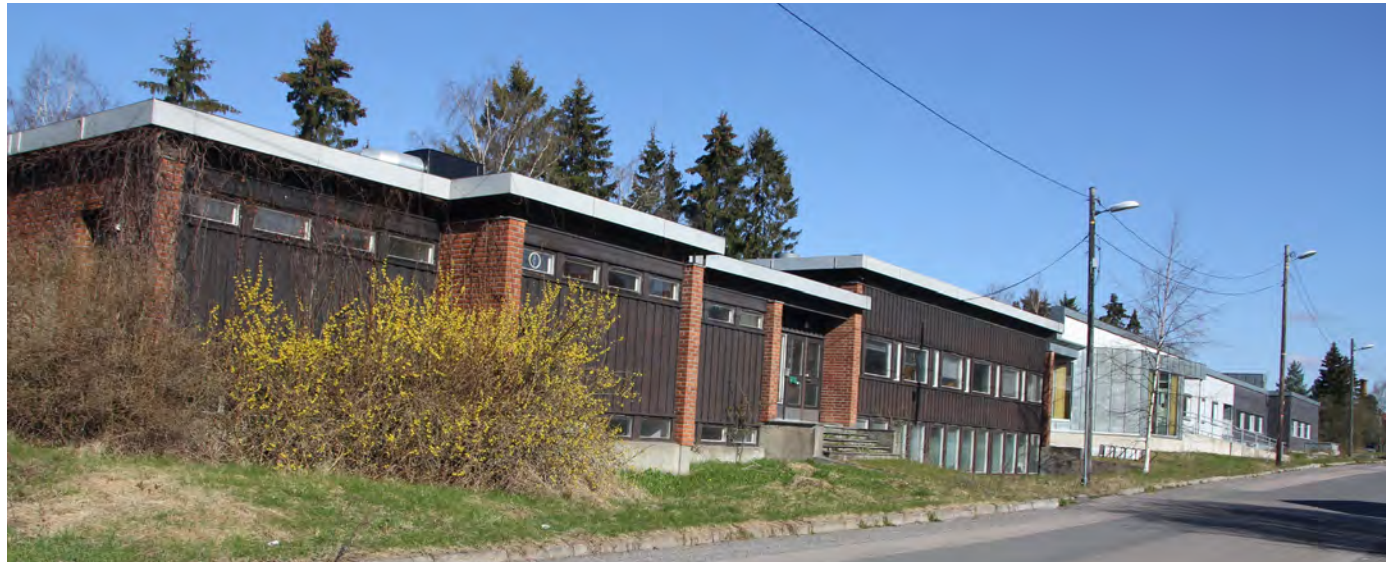
Utbygger vil gjerne rive eksisterende bebyggelse i Bogerudveien 15 og bygge høyhus med 4-5 etasjer. Foto: Leif-Dan Birkemoe, 26.04.2016.
