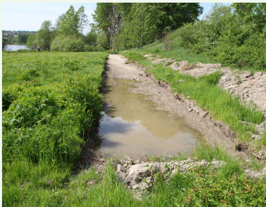
Turveitraseen legges nærmere skråningen fra jordene på Østensjø gård. Byantikvaren foretok sjaktgraving som del av en arkeologisk undersøkelse i desember 2017 før området kan fristilles til turvei. Foto: Leif-Dan Birkemoe, 21.05.2018.
