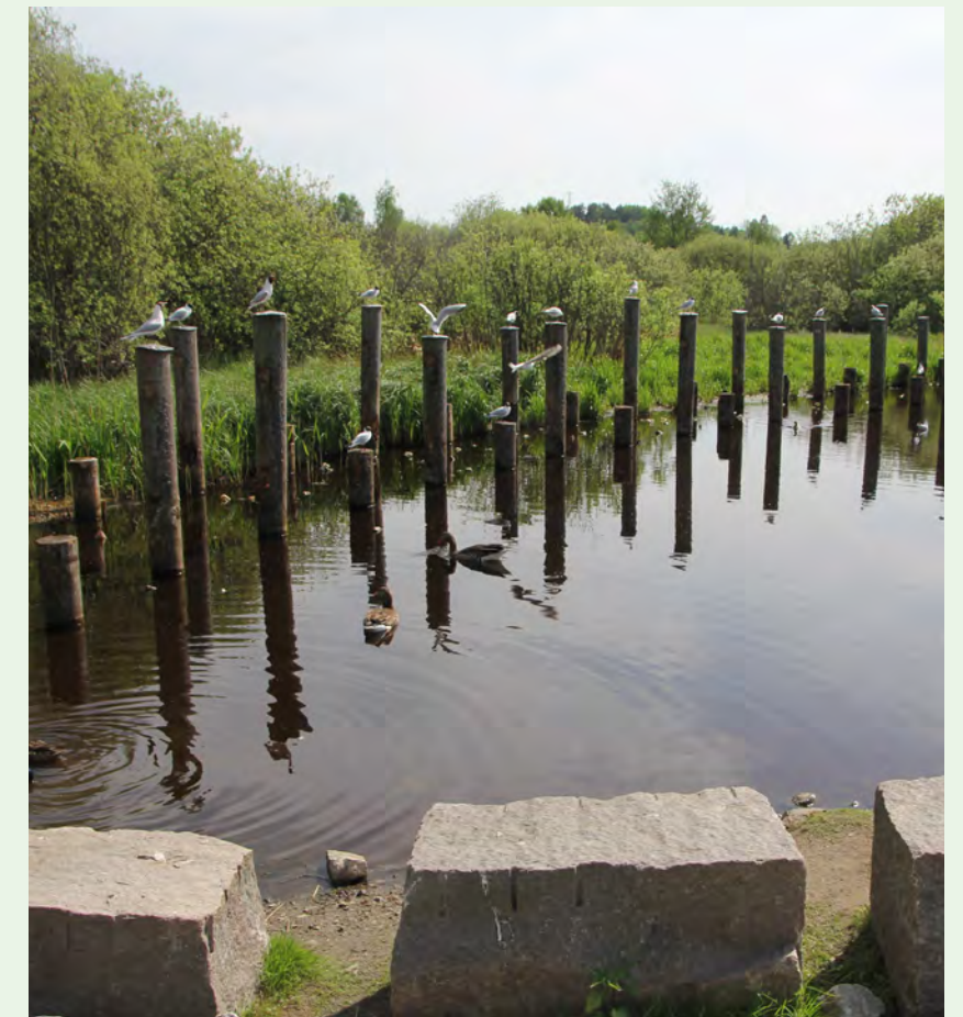
Stolpene er det eneste som er igjen av gangbroen og viser vannivåets høyde. Foto: Leif-Dan Birkemoe, 21.05.2018.
