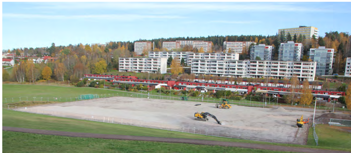
Nytt banedekke legges på kunstgressbanen på Rustadfeltet. Det er store inngrep når idrettsanlegg skal bygges. Foto: Leif-Dan Birkemoe, 23.10.2015.
