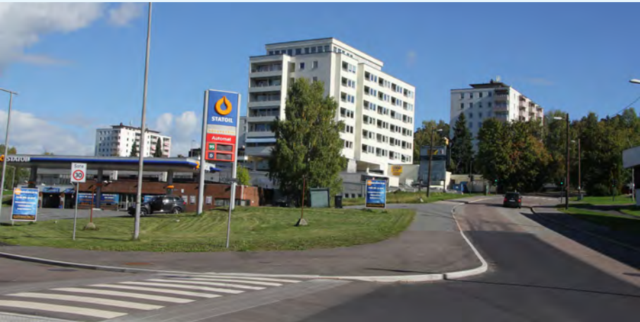
Bensinstasjonen som skal rives og boligprosjektet som skal bygges samme sted har adresse Låveveien 70 og ligger mellom to lukkede bekker, Godliabekken i Låveveien og Oppsalbekken i Haakon Tveters vei. Foto: Leif-Dan Birkemoe, 15.09.2017.
