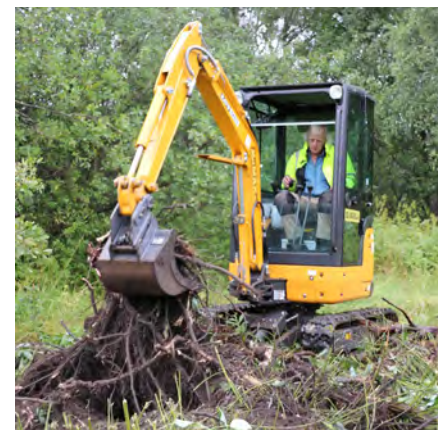
Eirik Wærner satt ved gravemaskinens spaker. Foto: Leif-Dan Birkemoe.
