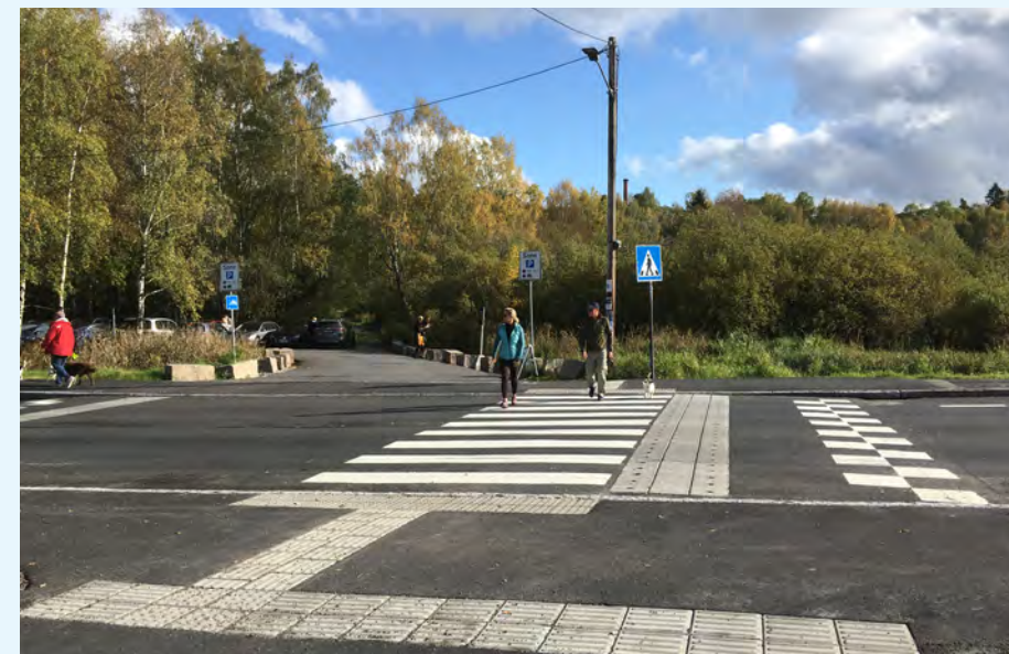
Det er nå ingen tvil om hvor fotgjengere skal passere over Østensjøveien. Likevel opplever vi enkelte konflikter mellom biler og fotgjengere. Foto: Leif-Dan Birkemoe, 29.09.2019.
