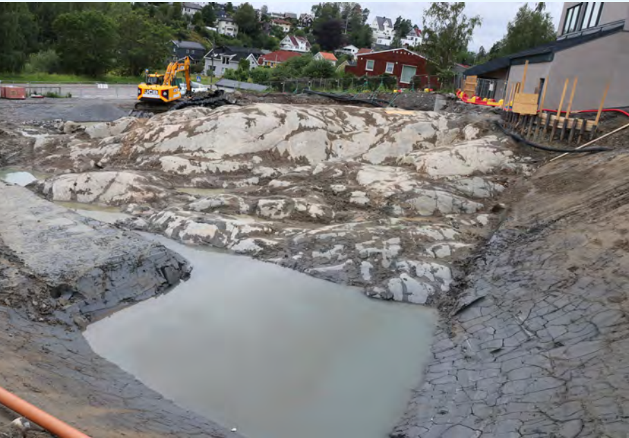
Skolebygningen til høyre ligger godt forankret på fjell. Rundsvaet eller svaberget strekker seg ned mot Østensjøveien og viser hvordan isen har slipt fjellet. Foto: 04.08.2019.
