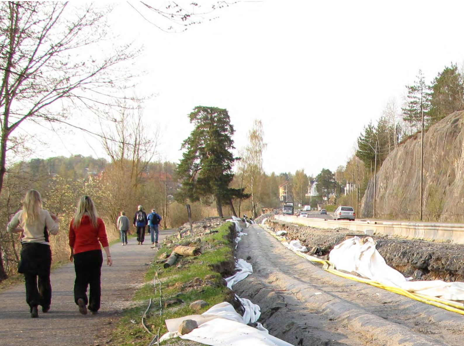
Her er fjernvarmerøret lagt langs Østensjøveien og passerer tett inntil furua uten å skade rota. Bildet er tatt 27.04.2009.
