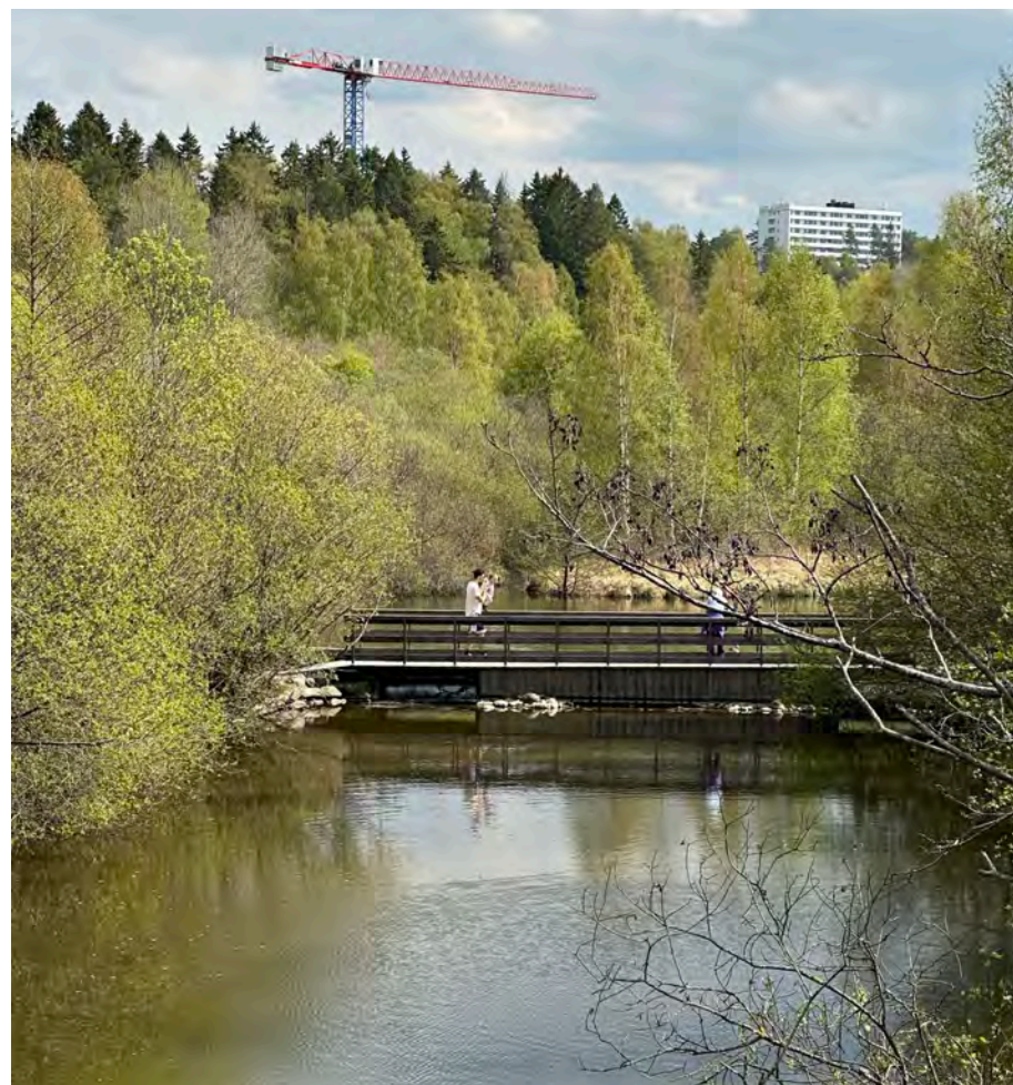
Kranen ved bygging av blokker i Bogerudveien 15 stiger opp av skogen sett fra Østensjøbroen. Foto: Leif-Dan Birkemoe, 14.05.2023.
