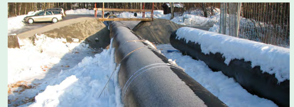
Det ble lagt to rørledninger (tur og retur) med ytre dimensjon 710 mm. Nå ligger rørene skjult uten å skade det biologiske mangfold eller er estetisk skjemmende. Foto: Leif-Dan Birkemoe, 02.02.2009.
