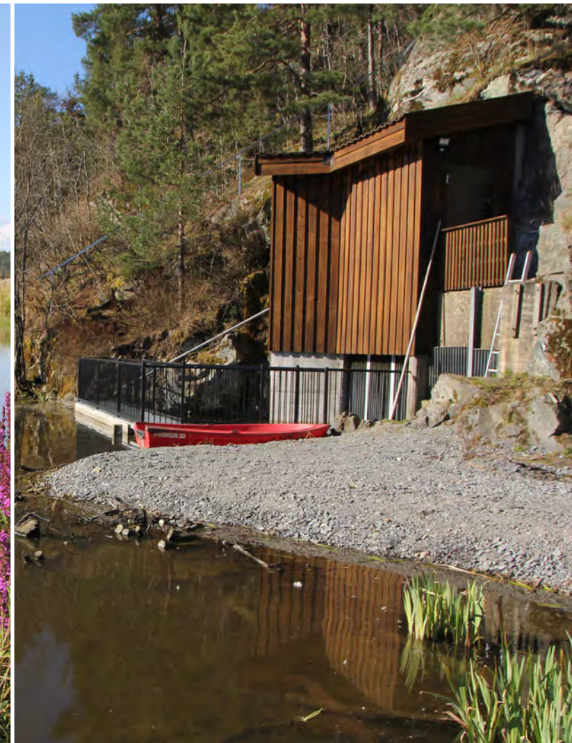
Østensjøvannet er et regulert vann. Damhuset i nord har innretninger for avløpet.
