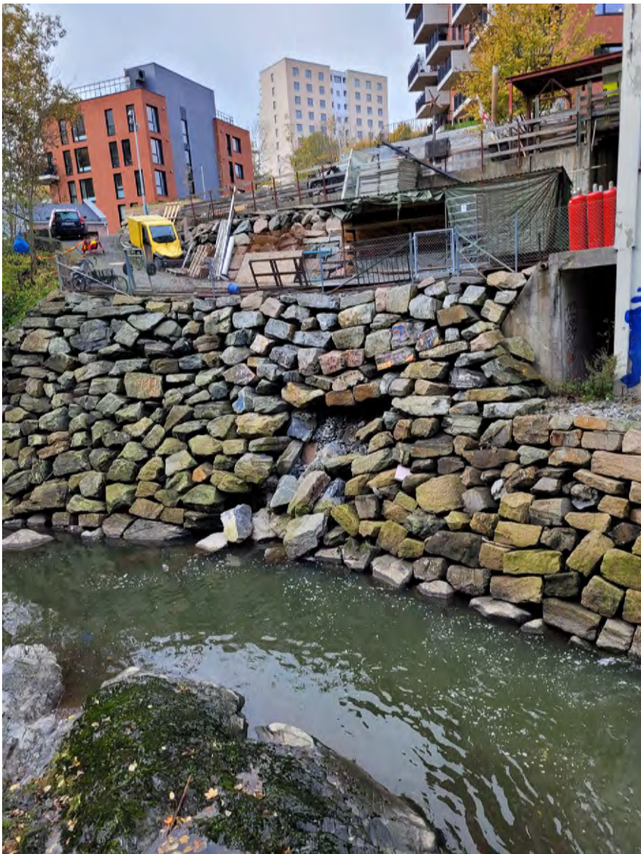
Bilde fra Kruttverket og den steinplastrede støttemur.
